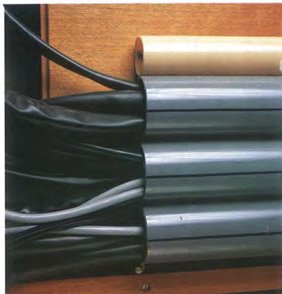
Alla kablar i en SRC är dragna genom brandsäkra rör. Om en kortslutning inträffar brinner inte plasten.
